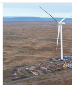
La planta de demostración Haru
